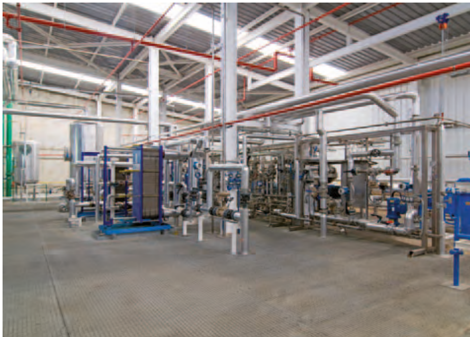
Edificio de Proceso: Biodiesel. Vista General Cota 7,5 m.
