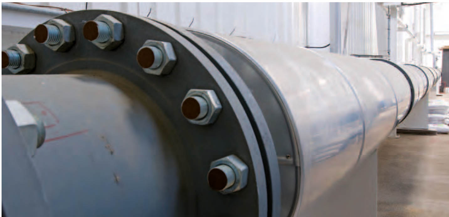
Reactor de Esterificación Ácida
