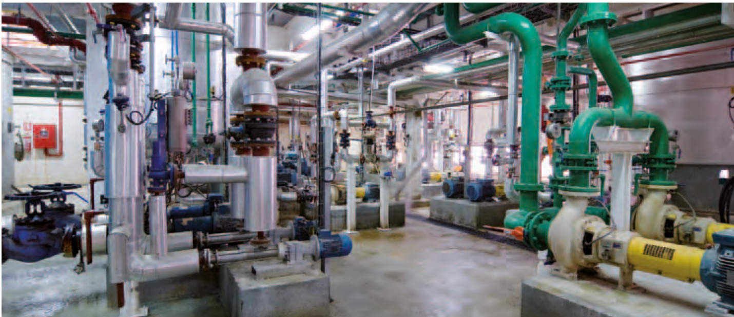
Edificio de Proceso: Refino de Aceite. Vista general cota cero.
