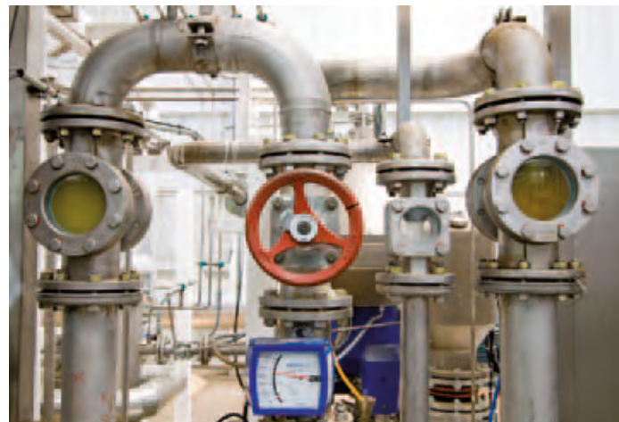
Mirillas de la Centrifuga de Lavado de Biodiesel
