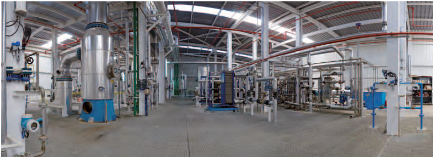
Edificio de Proceso: Biodiesel. Vista General Cota 7,5 m.
